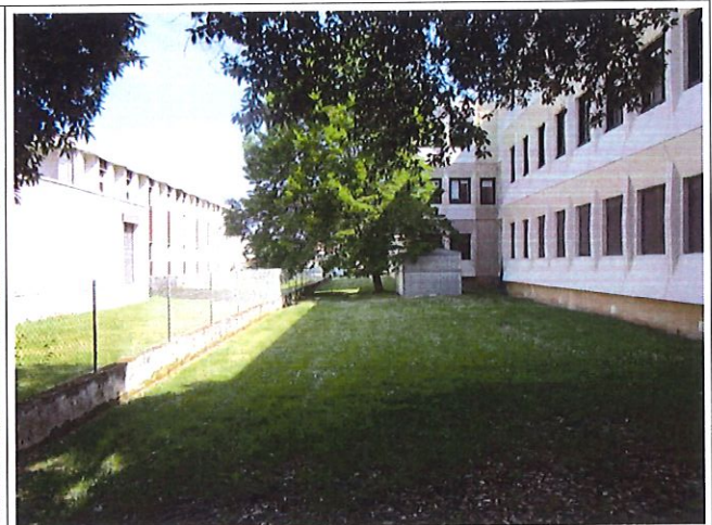
Existence d'une construction précaire
