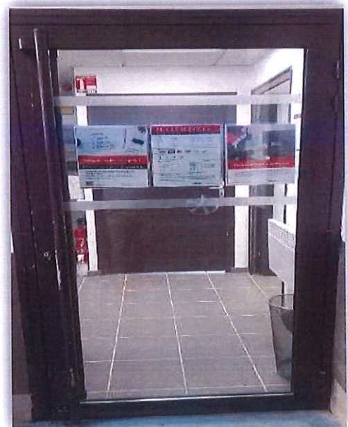
Porte vitrée bureau d'accueil Parking Centre-Ville.
