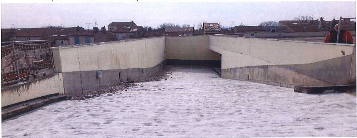
Ponçage de la couche de roulement
