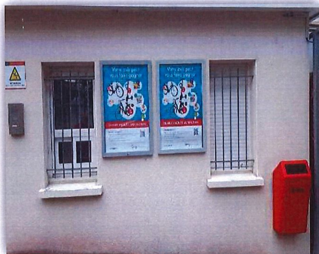
Mur local exploitation Parking du Bois d'Amour.
