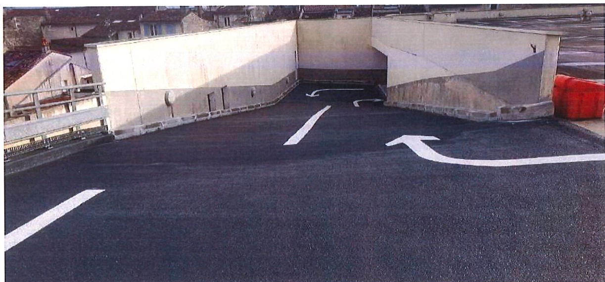
Mise en application de résine et nouvelle couche de roulement.
