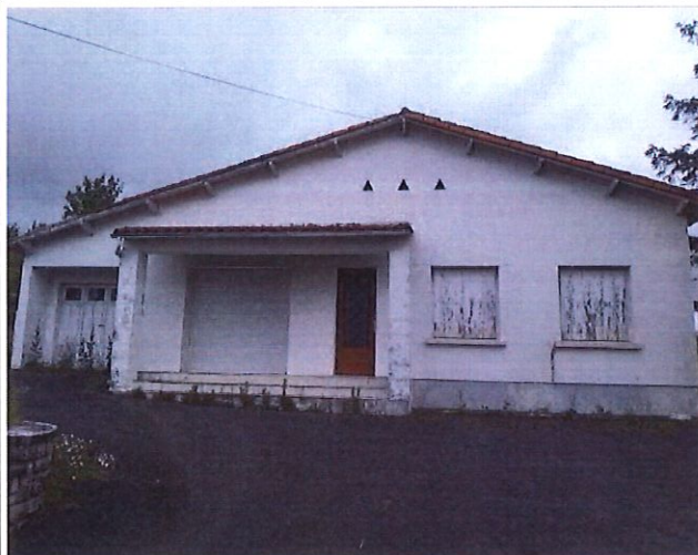
Auvent sur la façade de la maison.
